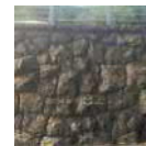
Torkkelimäen kivimuurit https://www.hs.fi/kaupunki/helsinki/art-2000006637182.html
