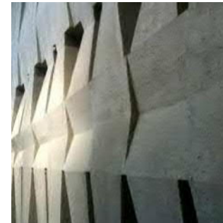
Osa muureista voidaan toteuttaa betonirakenteisina. Suurille muuripinnoille muodostetaan vaihtelua murtamalla suuret pinnat pienemmiksi sekä terassoituvilla istutustasoilla. Tavoite on välttää suurta, homogeenista muuripintaa.
