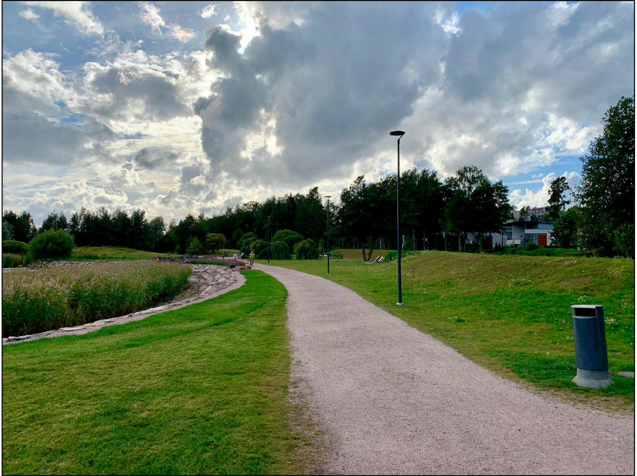
Kuva 5.2.1-1. Nuottaniemen tulvasuojaus Espoossa valmistui vuonna 2020.
