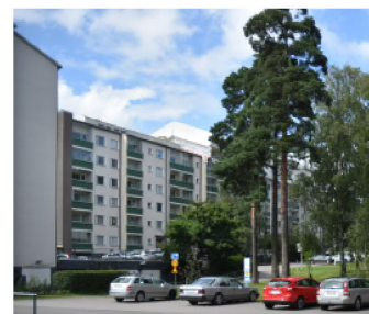
Tontti 4, rakennustunnus 9360 ja 9361
