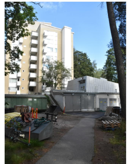
Tontti 2, rakennustunnus 9402 (lämpökeskus)
