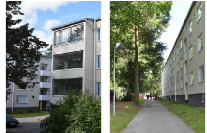
Tontti 1, rakennustunnus 9380 ja 9381
