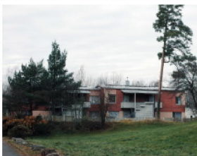
Tontti 5, rakennustunnus 9522 ja 9523
