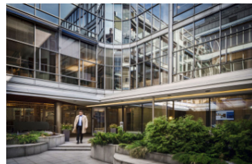
Lisärakennus Arkkitehtitoimisto Simo Järvinen & Co, 1984
