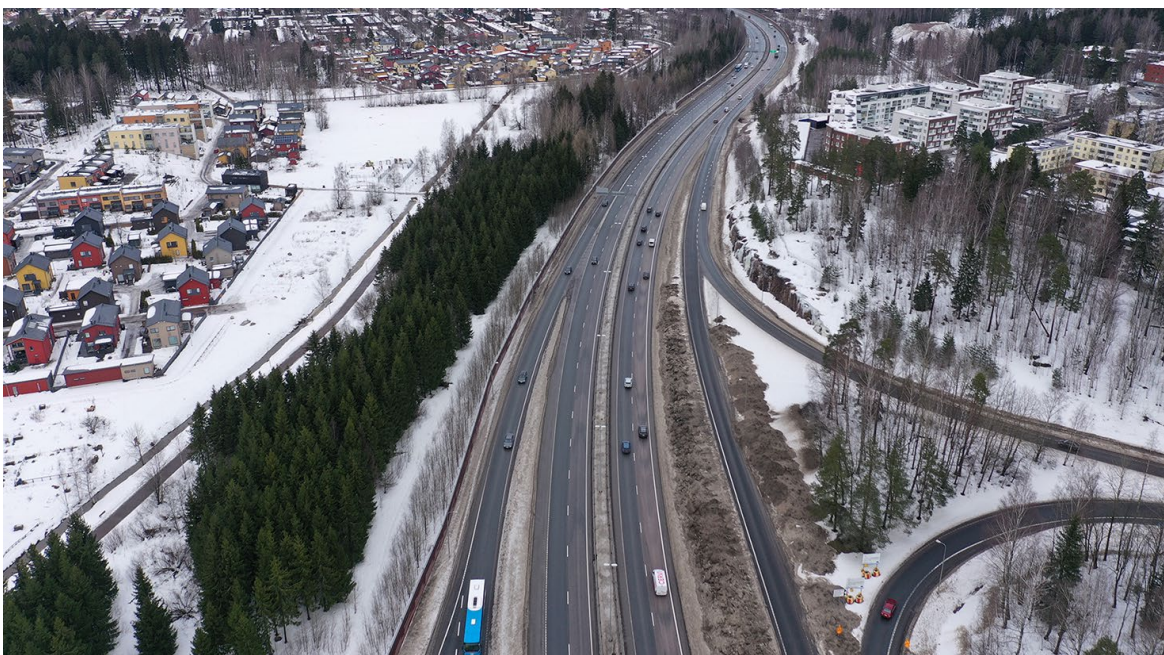
KUVA: Nykytila, Tuusulanväylä pohjoissuuntaan, vasemmalla moottoritien suojavaikykkeet ja melulaita
