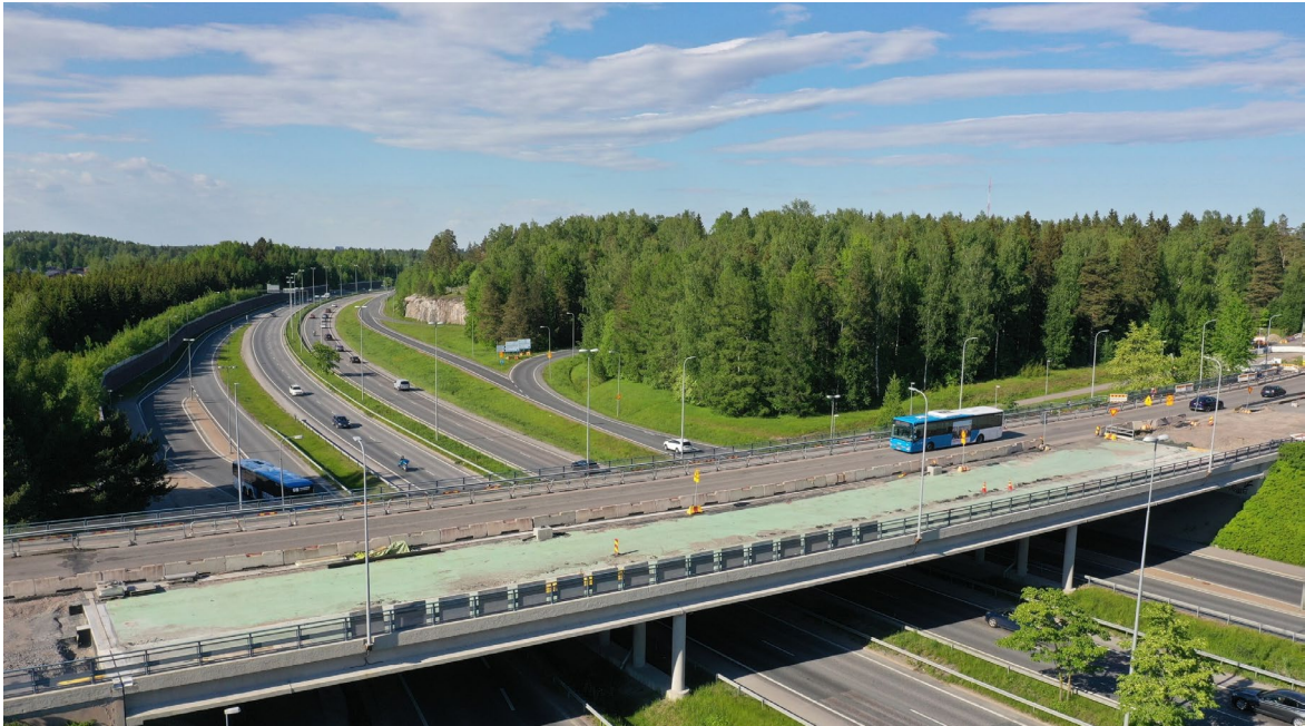
KUVA: Näkymä Käskynhaltijantien ja Pakilantien risteysalueelta, Raide-Jokeri rakenteilla (Voima Graphics Oy)
