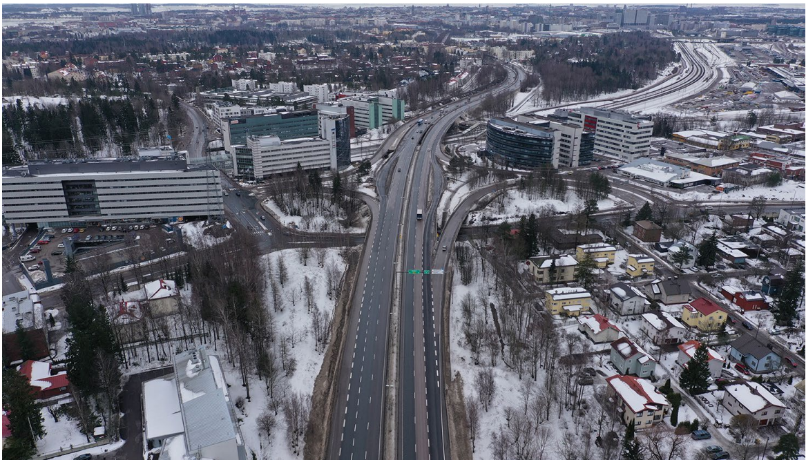
KUVA: Tuusulanväylän, Asesepäntien ja Mäkitorpantien risteys sekä Metsälän ja Oulunkylän reunavyöhykkeet etelään päin kuvattuna (Voima Graphics)
