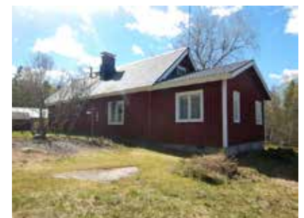
Torppa koillisesta. Oik. 1970-luvun laajennus.
