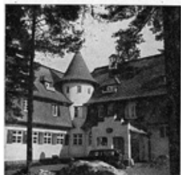
Kantarnäs gård; tak av röda asbest-plattor.
