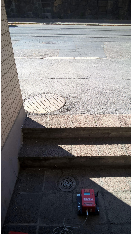
Kuva 5.3. Mittauspiste MP1 maanpinnassa. Kaarlenkadun kiskot näkyvät taustalla.
