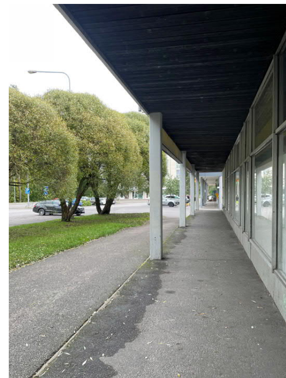
7. ja 8. Katetut kulkureitit rakennuksen julkisivuilla.
