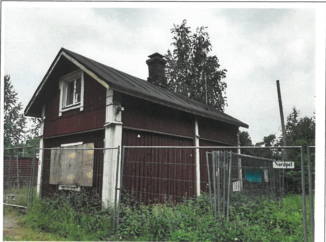
Kuva 6 Julkisivu pohjoiseen ja itään
