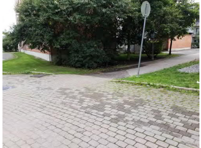
Kuva 68. Kaupparaitilla kunnostetaan mm. pintamateriaalit ja rakenteelliset ongelmat.
