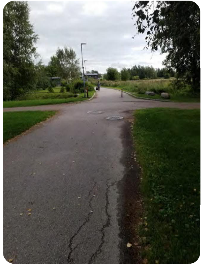
Kuva 40. Sammalpolun liittyminen Helluntairaittiin.
