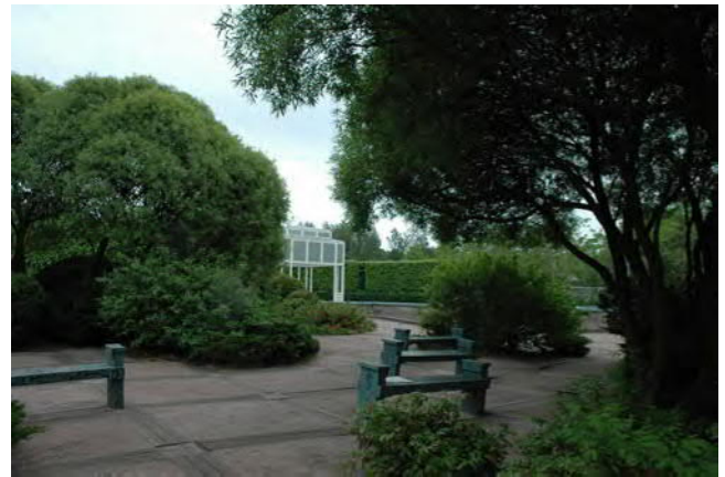
Kuva 71. Ala-Malmin puiston huonokuntoiset kalusteet ja varusteet uusitaan.
