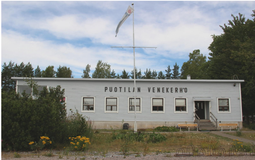
Puotilan venekerhon kerhorakennus (rakennusvuosi 1988), puretaan
