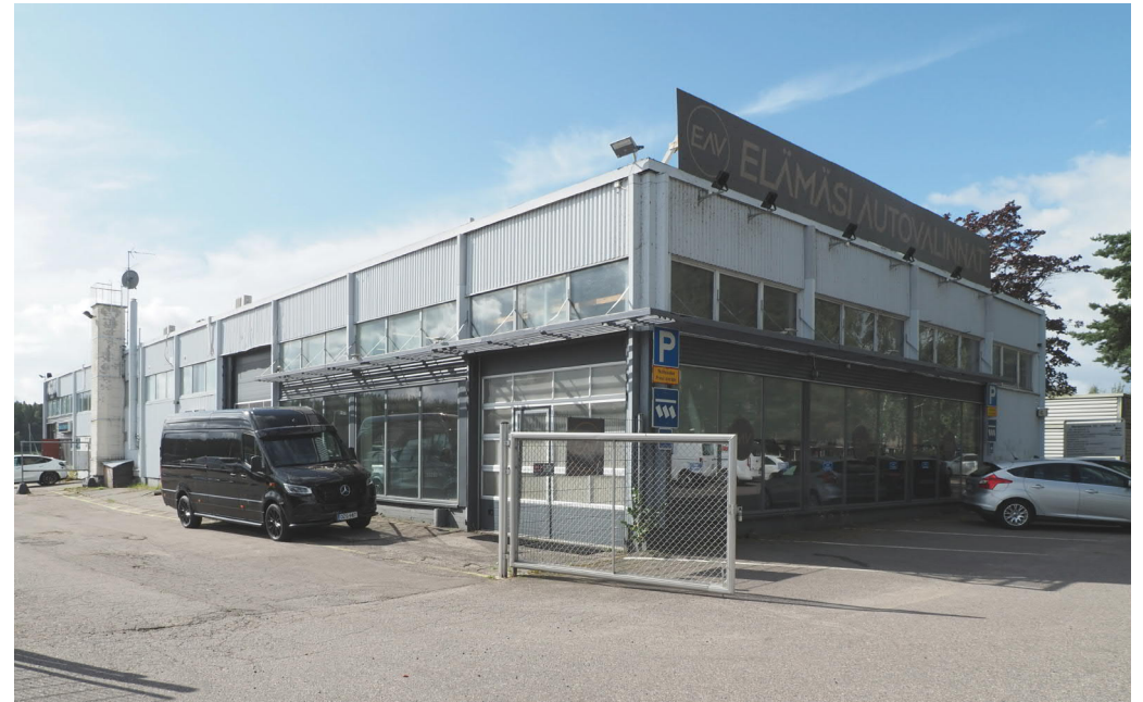
Puotilan satama-alueen tyypillistä rakennuskantaa, myymälärakennus (rakennusvuosi 1973), puretaan
