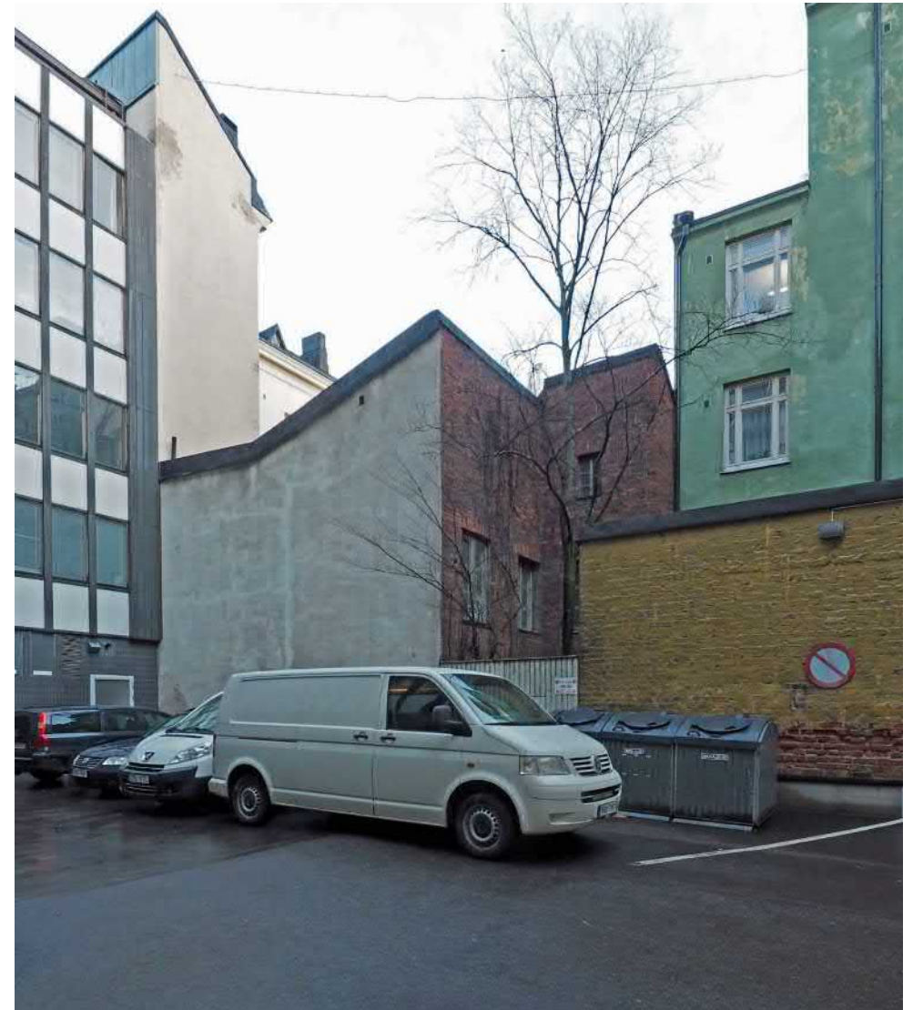
Näkymä Eerikinkatu 6:n sisäpihalta
