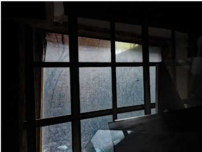
Näkymä kellaritilasta vieriselle pihalle
