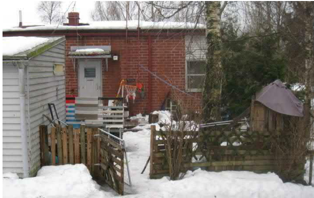
Asukkaan rakentamia aitoja
