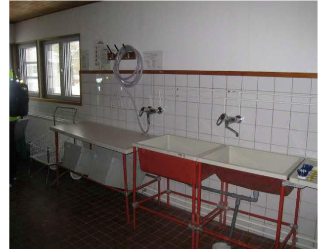
Talopesulaan on lisätty seinälatoitusta ulkoseinille
