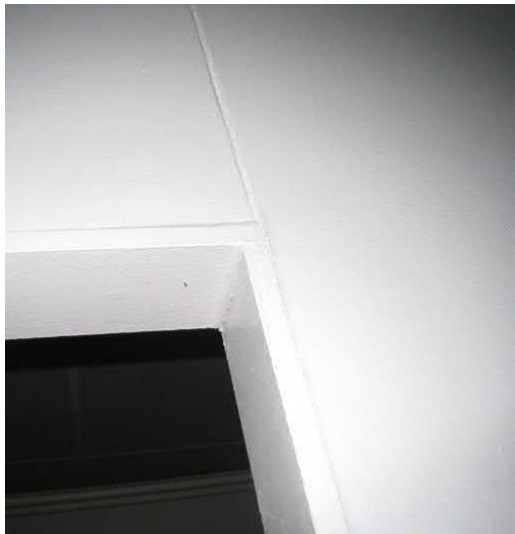
Ovettoman aukon listoitus, levyseinissä on v-urasaumat
