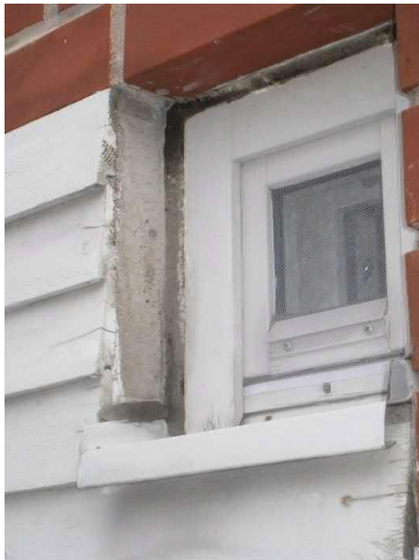
Ikkunan liitosdetaljintia tiilijulkisivun lauta- verhoillun osan rajassa
