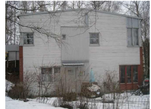
Alkuperäinen räystäspellititys päädyssä
