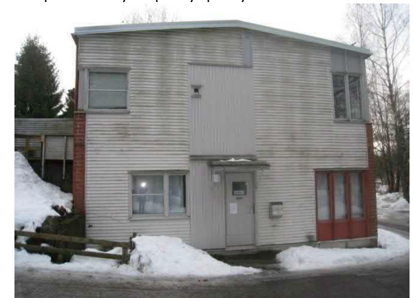
Räystäspellit uusittu päädyssä
