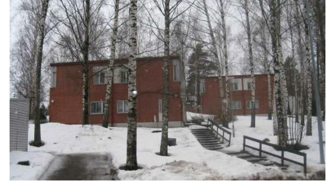
Myllärintietä pitkin kulkiessa tiilijulkisivut
