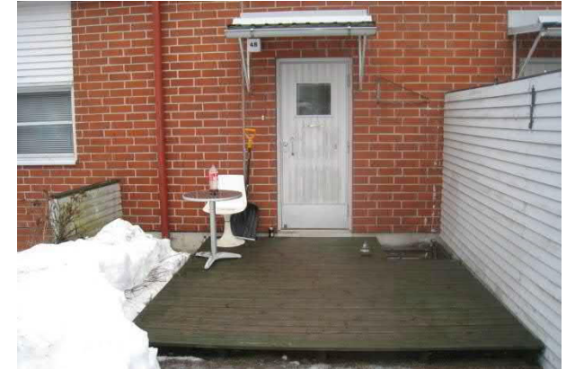
Sisäänkäynti asuntoihin kulkee asuntopihan kautta, peruspiha
