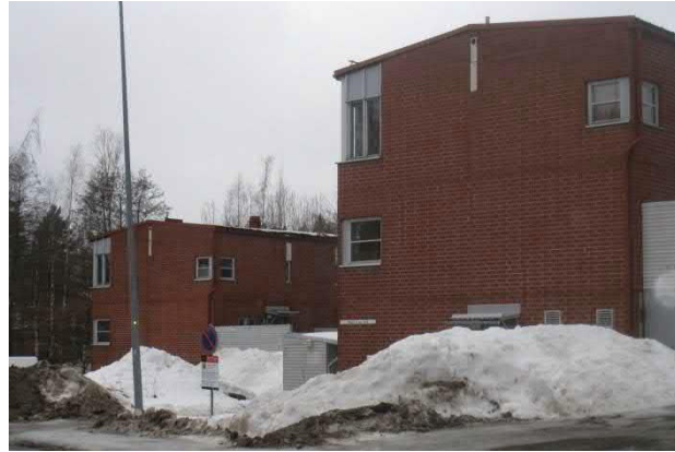
3-kerroksisten talojen 1-3 päädytkin ovat tiililaattapintaisia
