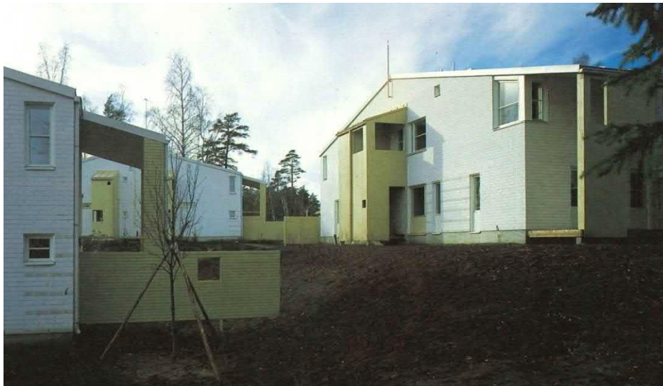
As-oy Viikkokuja, näkymä tontilta kohteen valmistuessa Lähde: Arkkitehti-lehti 7/1986
