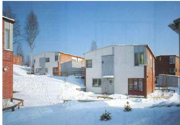
Kuva tontilta valmistumisen jälkeen Lähde: Tiili-lehti 1/1988
