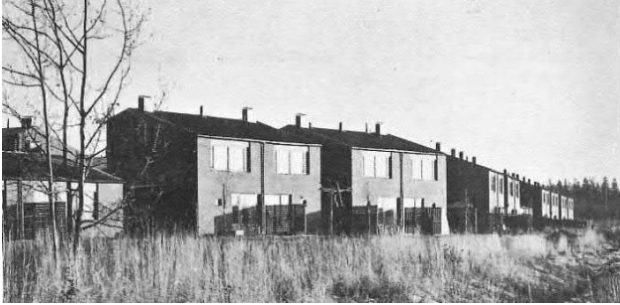
As-Oy Revontulentie 4 rakennuksia
