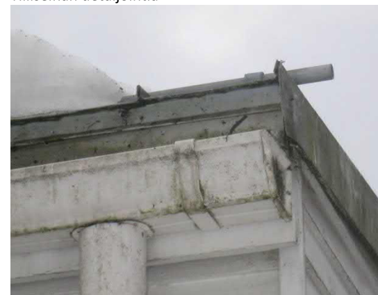
Alkuperäinen päätyräystäspeltti talossa 24
