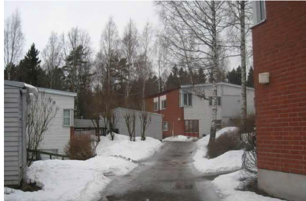
Tiili- ja puujulkisivujen vaihtelua
