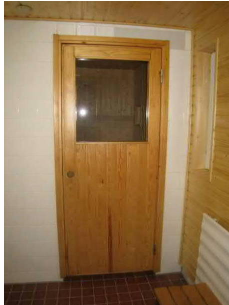
Pesuhuoneessa ulkoseinällä on uusittu panelointi
