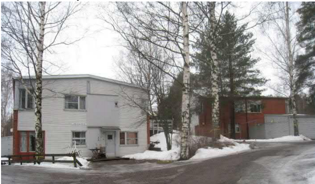
Rakennusten päädyt ovat yleensä puuseiniä lautaverhouksella
