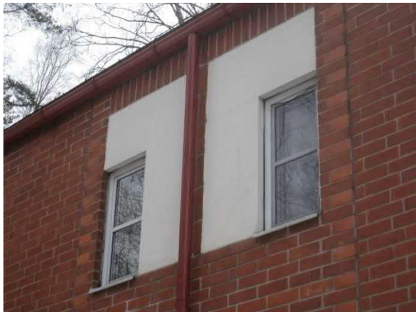
Tiilijulkisivun tehosteosat ovat maalattua betonia
