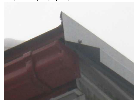
Uusi päätyräystäspeltti lisätty vanhan päälle
