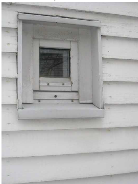
Ikkunan liitokset lautaverhoillussa julkisivussa
