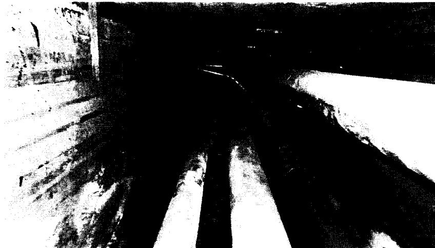
Kuva 7: Pohjolankatu 47 rakennusten alapuolinen tekniikkakanaali
