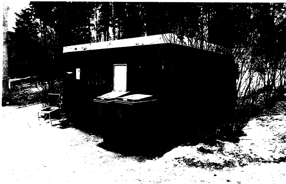
Kuva 3: Pohjolankatu 47 puoleinen jätekatos
