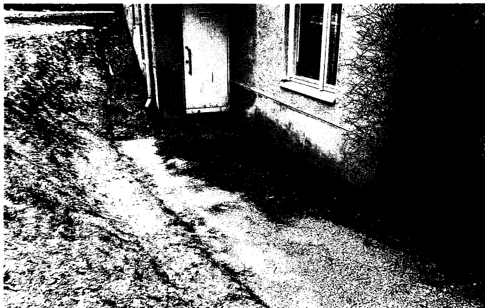
Kuva 6: Pohjolankatu 47 sokkelirakennetta, sepelikaistoja ei ole
