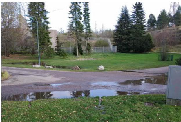
Kuva 20. Johannesbergintiessä rosariumin pohjoispuolella on painumia ja pintavesien kuivatus ei toimi. Sadevedet pääsevät huonosti Johannesbergintien itäpuolelta sen länsipuolelle kohti ojaa ja merenlahtea.
