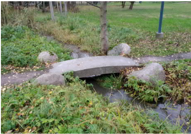
Kuva 129. Pieni kävelysilta ylittää ojan pienen polun kohdalla.
