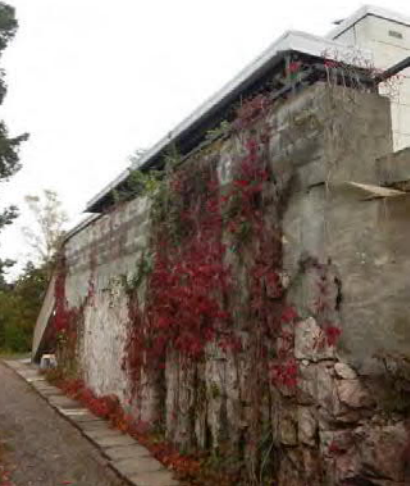
Rakennuksen länsipuoli, kalliota, lautamuotin jälkiä
