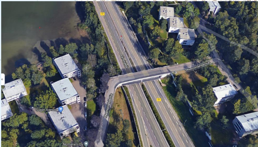
Maamonlahdentien silta, google maps
