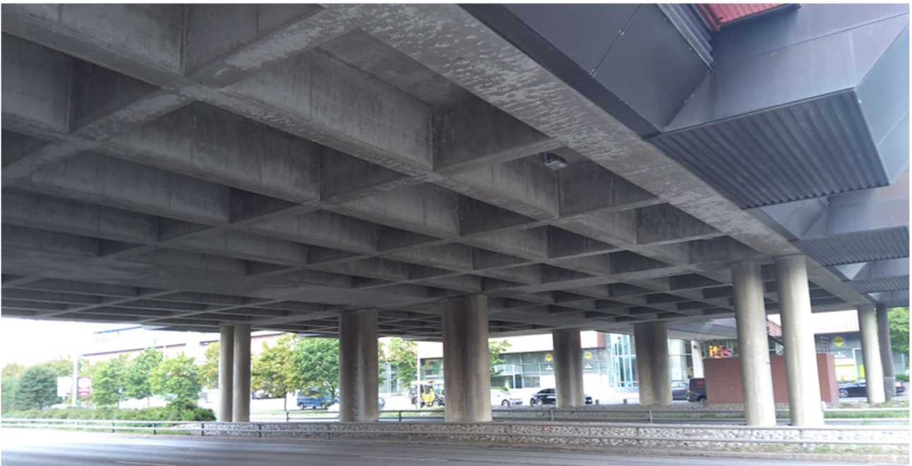
Hansasillan alapohjan betonirakenteita © Maria Ailio 2022
