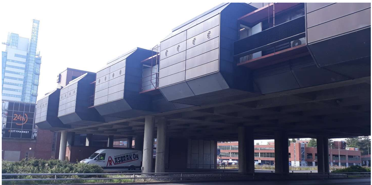
Hansasillan kuparin sävyyn anodisoitua alumiinikasettipintaista itäjulkisivua © Maria Ailio 2022
