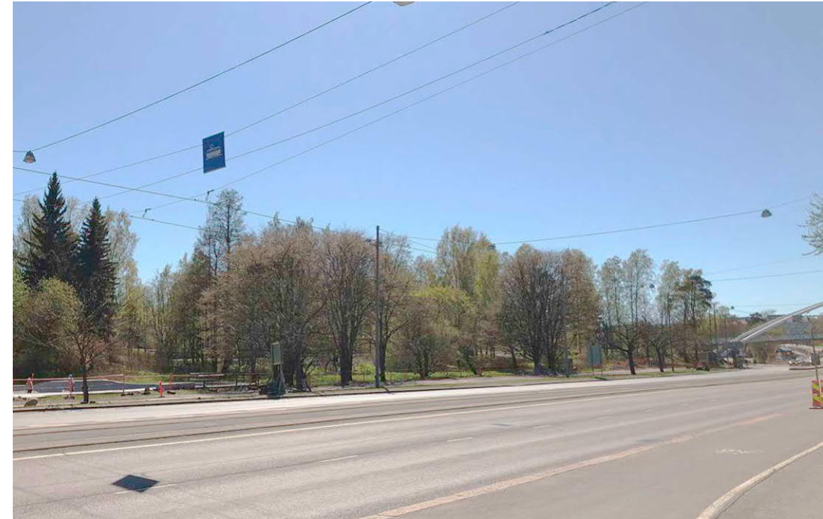
4. NÄKYMÄ PASILAN SUUNNASTA KOHTI ELÄINTARHAA, KALLIOTILOJEN MAANPÄÄLLISET IV-RAKENNELMAT
