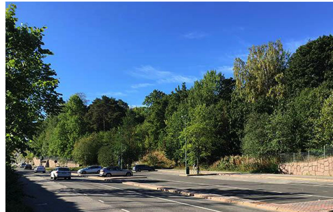
7. NÄKYMÄ VAUHTITIEN TUNNELINAUKOKSTA
