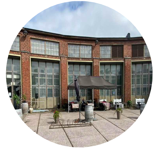
TIILI JA RATAKISKOT
