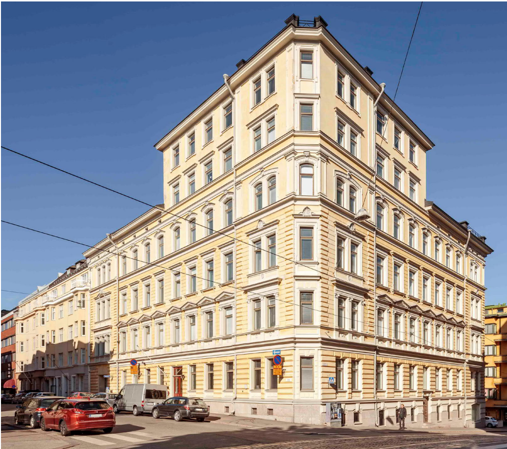
Yrjönkadun ja Ratakadun kulmassa rakennusta korotettiin kahdella asuinkeroksella vuonna 1934.
