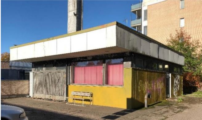
Lämpökeskus edestä kuvattuna
