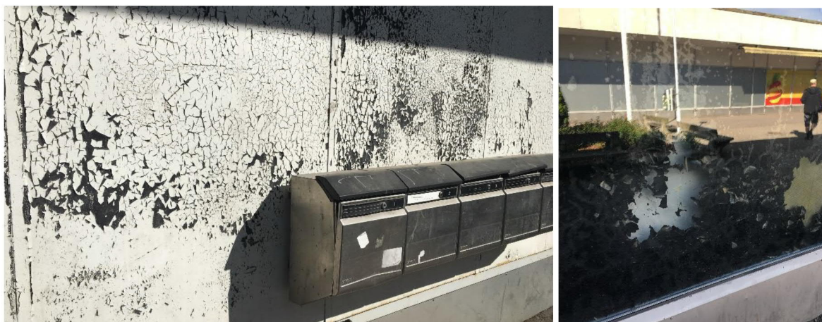
Sisäpihan julkisivujen seinä- ja näyteikkunapintoja nykytilassaan
