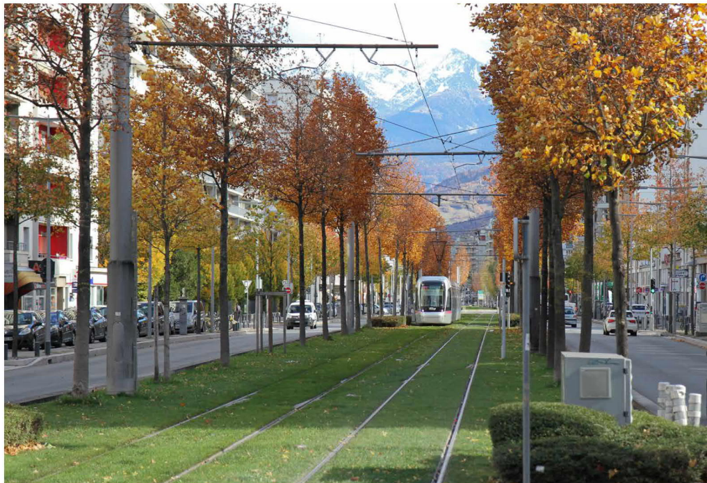
Kuva 77 Pikaraitiotie nurmiradalla Grenoblen kaupungissa. (Kuva: Davy Beilinson)
