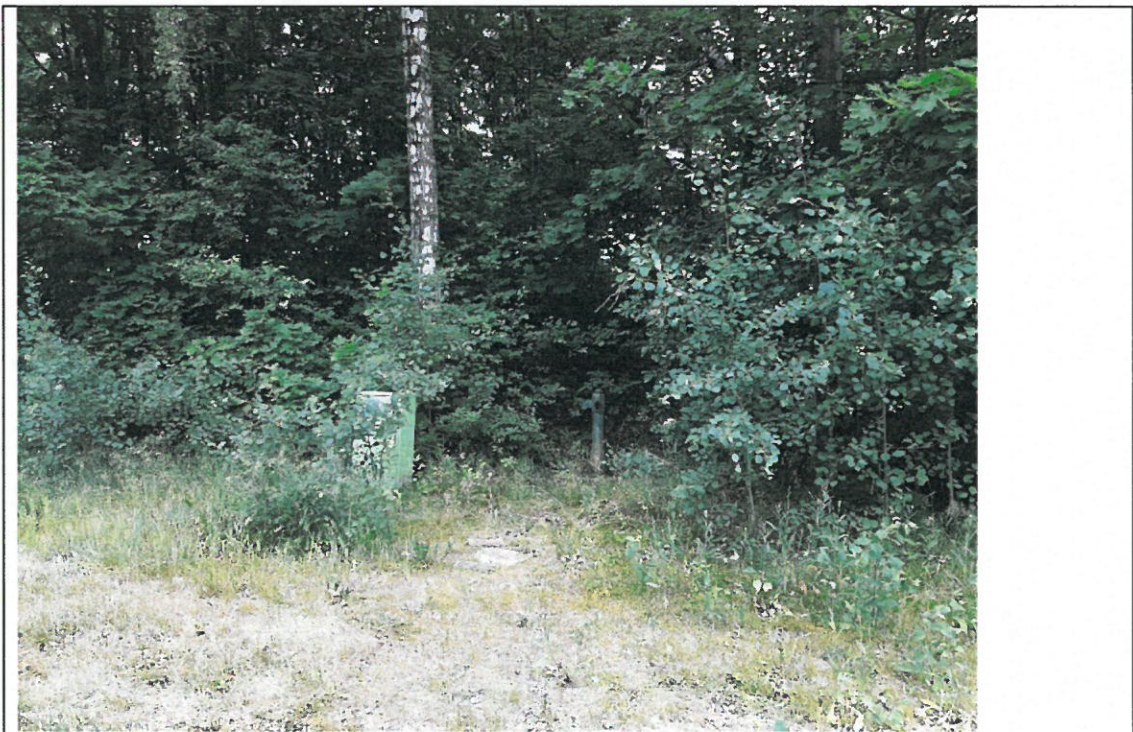
Kuva 2 Tien vieressä vesipiste sekä sähkökaappi
