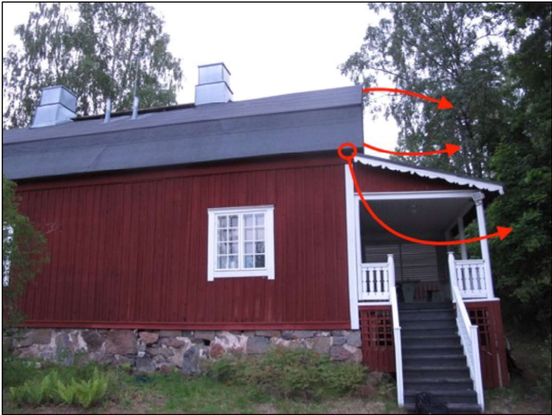
Liite 4. Kaivoshuvilan lepakkoyhdyksunnan todetut ulostuloaukot kesällä 2018. Nuolet ylhäältä alkaen: koillispuoleisen päätykolmion ylänurkassa räystään alla, päätykolmion vasemmassa alakulmassa, sekä rakennuksen kaakkoiskulmalla räystään alla.
