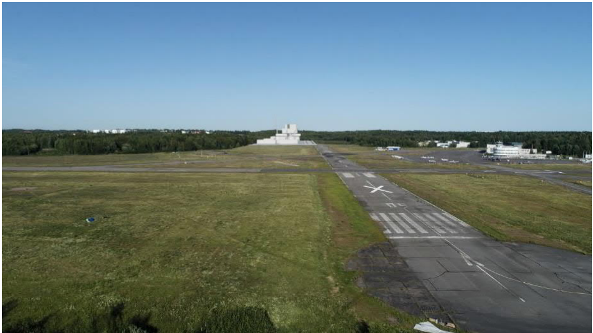
Kuva 8-26. Havainnekuva Malmin lentokentän länsirajalta kohti itää (Virkkunen&Co 2018). Sijoitusvaihtoehdossa VE2 lämpökeskus näkyy avoimessa lentokenttäympäristössä hallitsevana elementtinä ja on maiseman selkeästi suurin rakennus.
