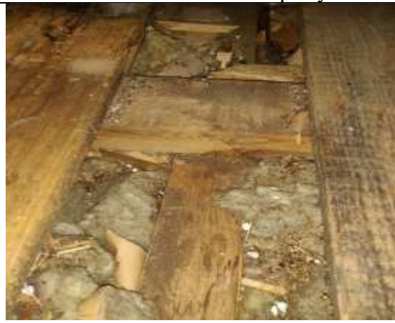
Kuva 16 välipohjarakennetta
