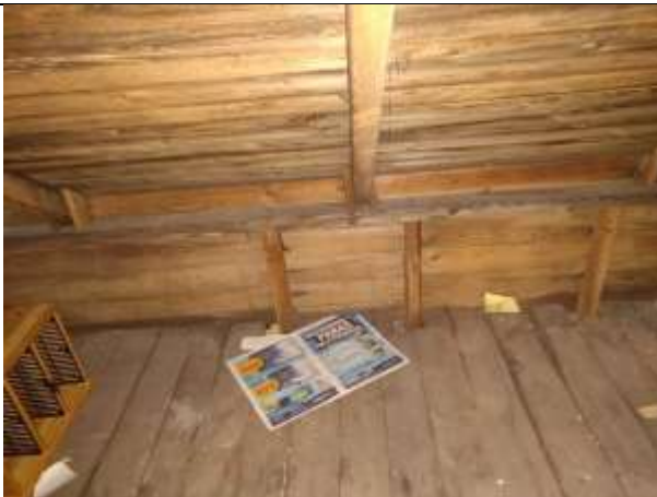
Kuva 15 Pitkän seinäosan vaakapanelointia, sekä kattorakennetta.
