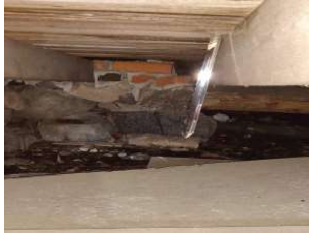
Kuva 8 Kuva rakennuksen alta, villaveitsi laudoituksen välissä.
