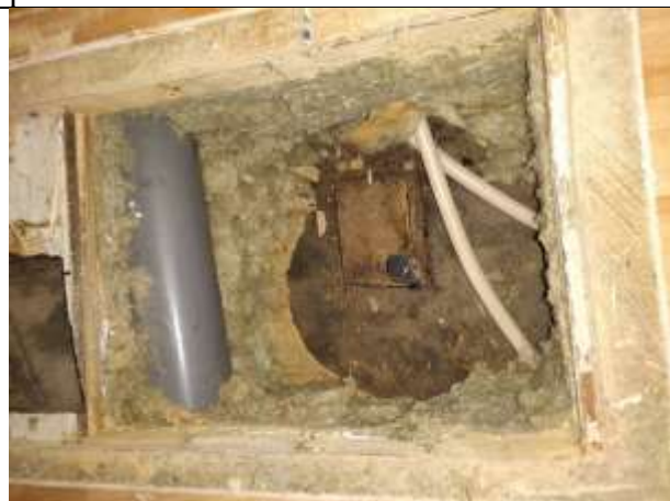
Kuva 6 Huoneiston D2 lattian avausta
