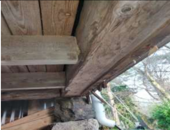
Kuva 1 Hirsinen alapuu, johon lankut ovat kiinnitetty, yläpuolella harva laudoitus
