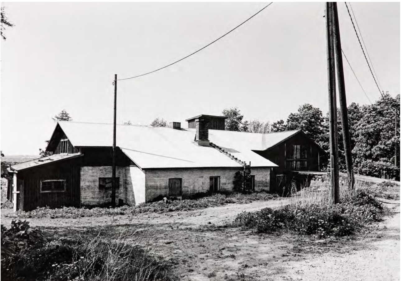
Kaarelan kartanon purettuja rakennuksia. Runonlaulajantie 46 Hakuninmaa. Kuvat: Roos C-G, 1975, HKM.
