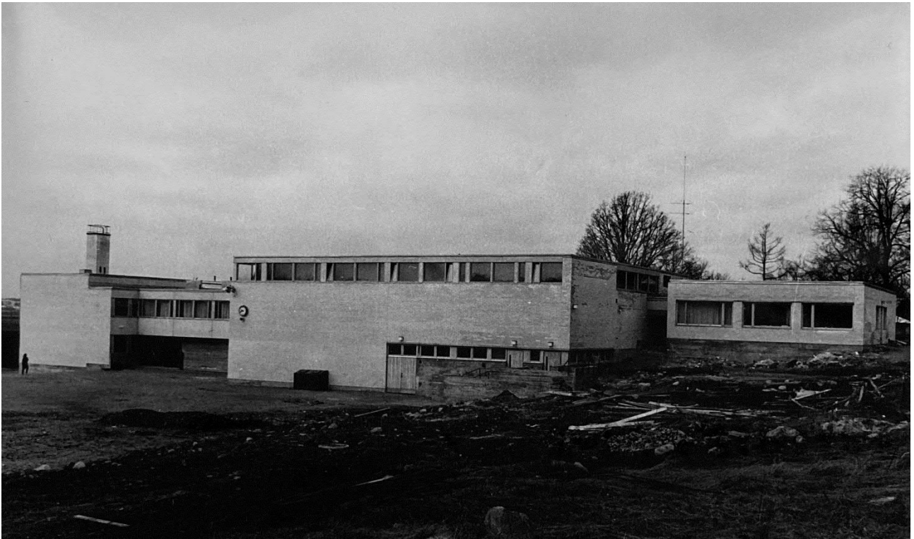
Ensimmäinen rakennusvaihe valmistumassa. Kuva: valokuvaaja tuntematon, ajankohta mahdollisesti vuosina 1966-1967, Fotoni.
