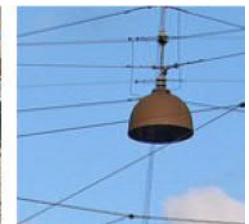
RIPUSTETTU VALAISTUS Esim copenhagen valaisin, jota on käytetty myös Jätkäsaarella.
