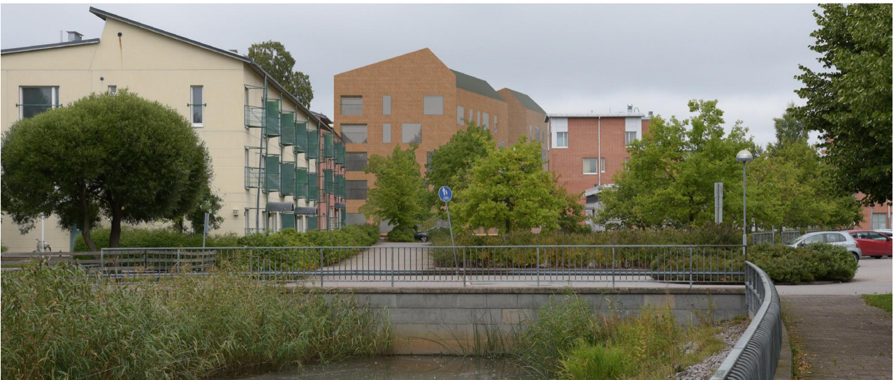
Näkymä Muusantorin eteläpuolelta
