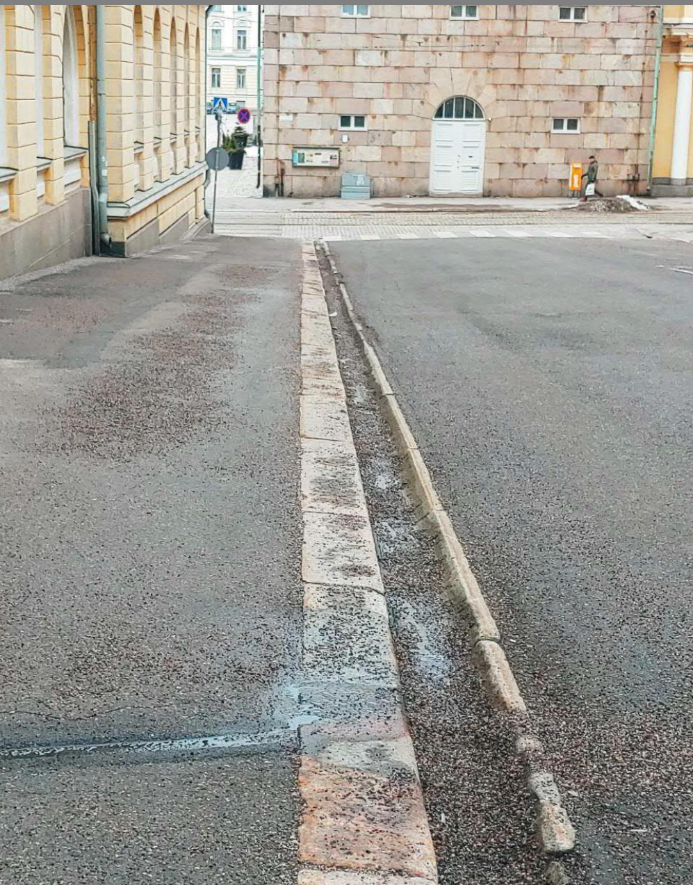
Hallituskadun kadun ja jalkakäytävien graniittikivi- ja asfalttipinnoitteet
