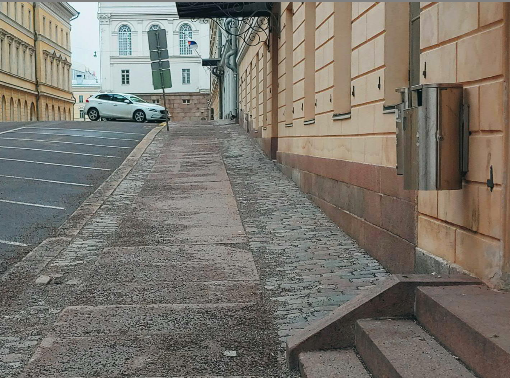
Hallituskadun kadun ja jalkakäytävien graniittikivi- ja asfalttipinnoitteet
