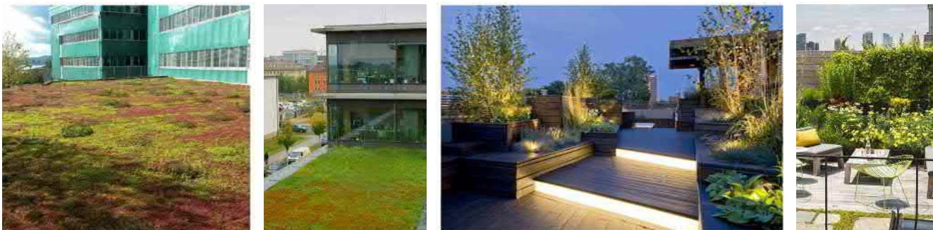
Esimerkkejä ekstensiivisistä viherkatoista, joilla erityyppisiä maksaruohomattoja, sekä erilaisista kansiphojen ratkaisuista.
