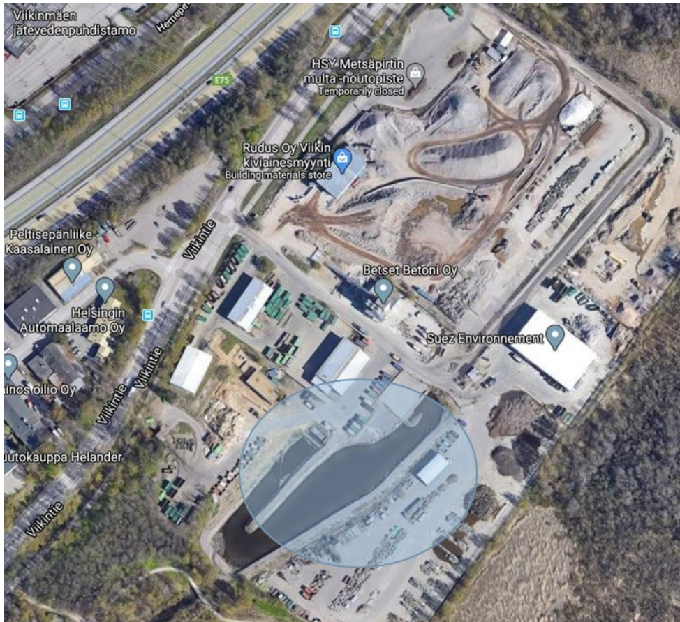
Kuva 4. Viikin puhdistuslaitoksen yhteyteen rakennettu sulatuslaitos
