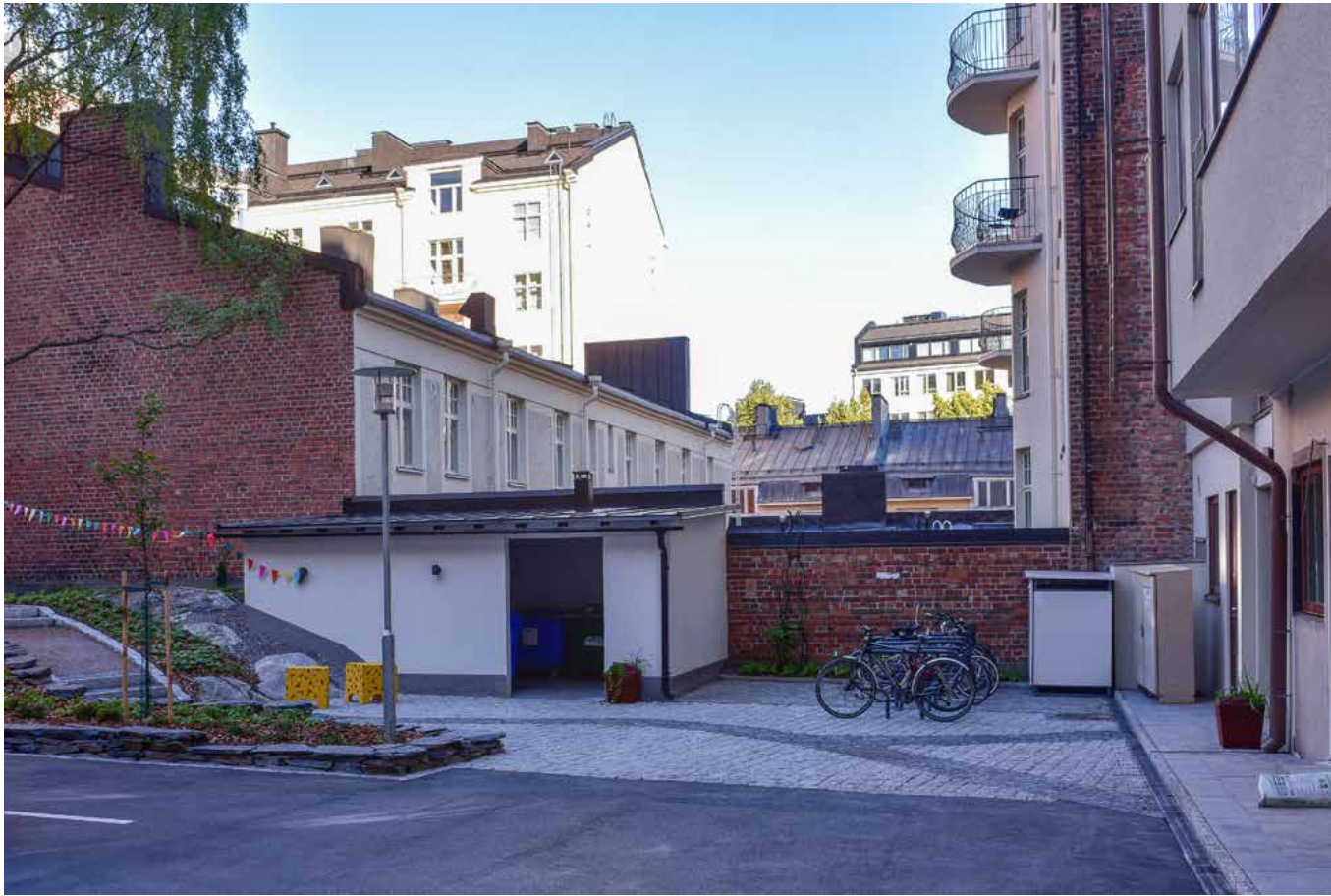
VALOKUVA SISÄPIHALTA, UUSI JÄTEHUONE JA UUDET PIHAJÄRJESTELYT
