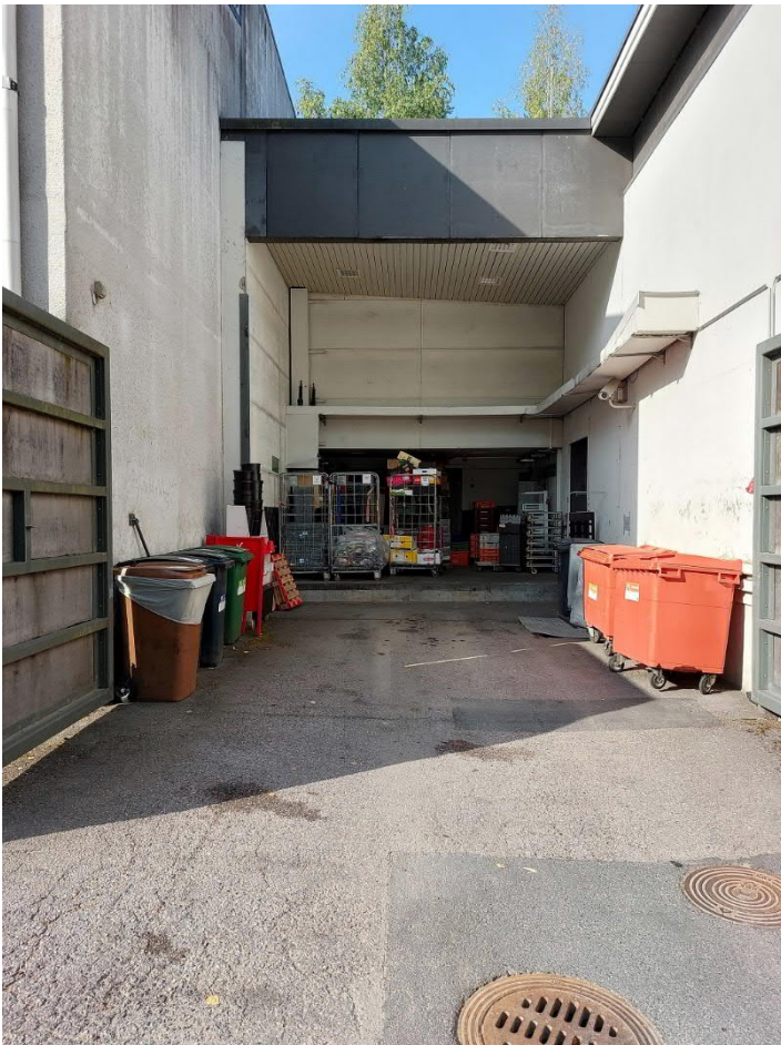
Kuva 6. Lastauslaituri ja jätetila.
