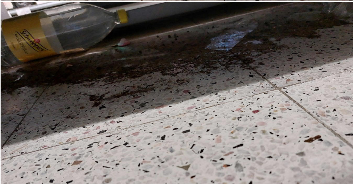
Kuvat 3 ja 4. Pinttymää ja roskaa myyntikalusteiden alla
