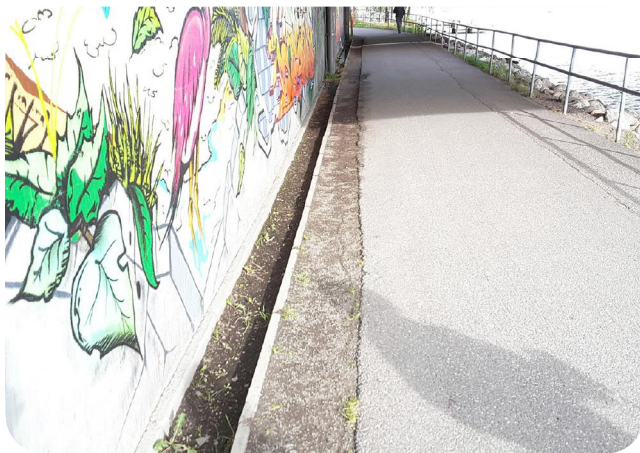
Kuva 69. Päällysteen rajautuminen kouruun ja kourun kunto.
