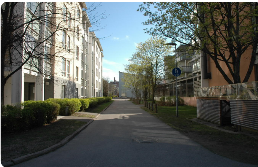
Kuva 47. Herttoniemenrannassa on kattava, ajoneuvoliikenteestä eroteltu kävelyn ja pyöräilyn reitistö, joka on tiivissä kaupunkirakenteessa ilmeeltään puolijulkinen. Näkymä Linnanrakentajantieltä Rouvienpolulle.
