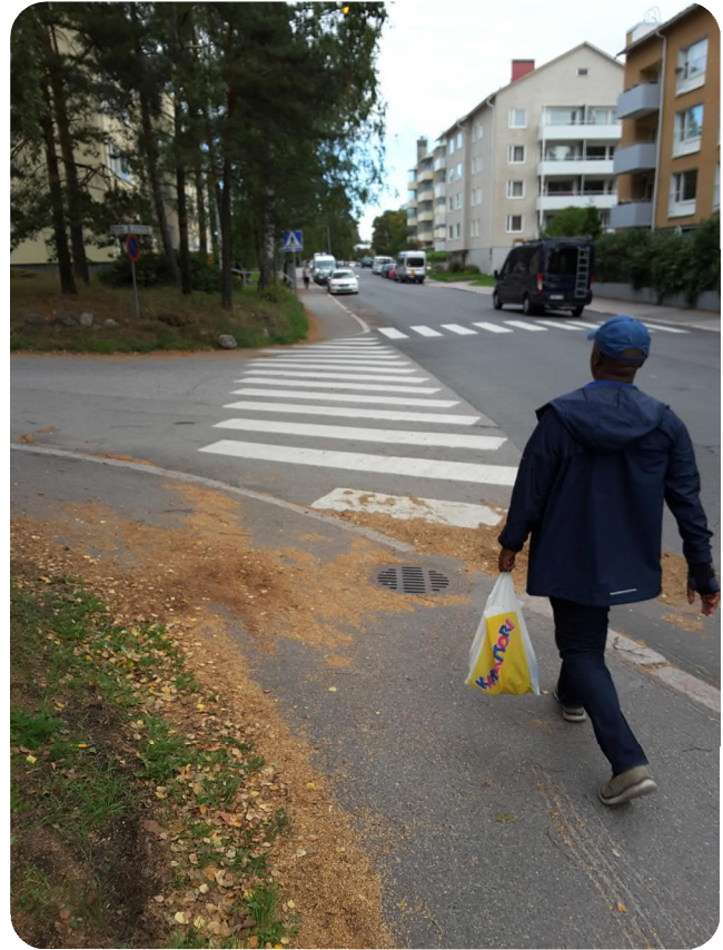
Kuva 45. Puutteellisia suojatieratkaisuja Hiihtomäentienellä.
