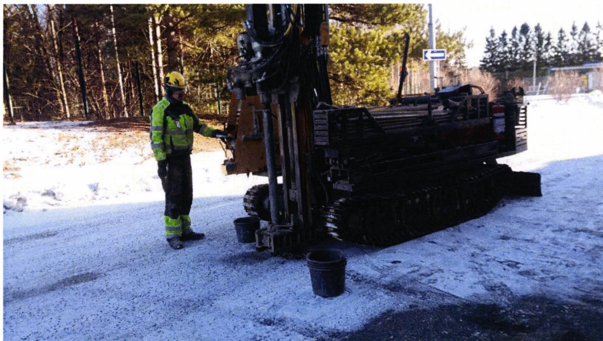
Kuva 5. Rakennuksen itäpuolella sijainnut näytepiste S5.
