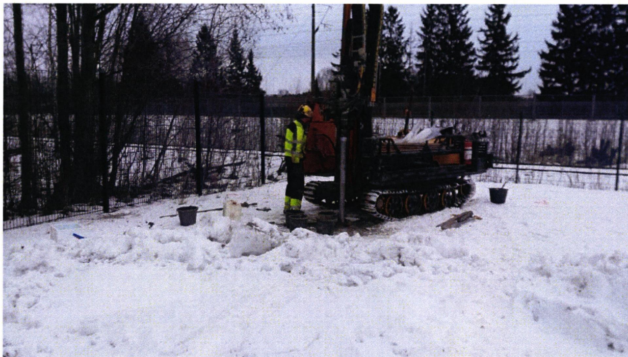
Kuva 1. Kiinteistön itäreunalle asennettiin pohjavesiputki GA1 (näytepiste S1).
