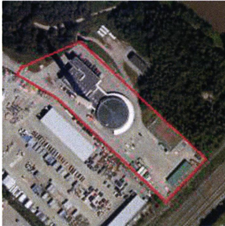
Kuva 2. Patolan lämpökeskuksen perustilaselvityksen rajaus.
