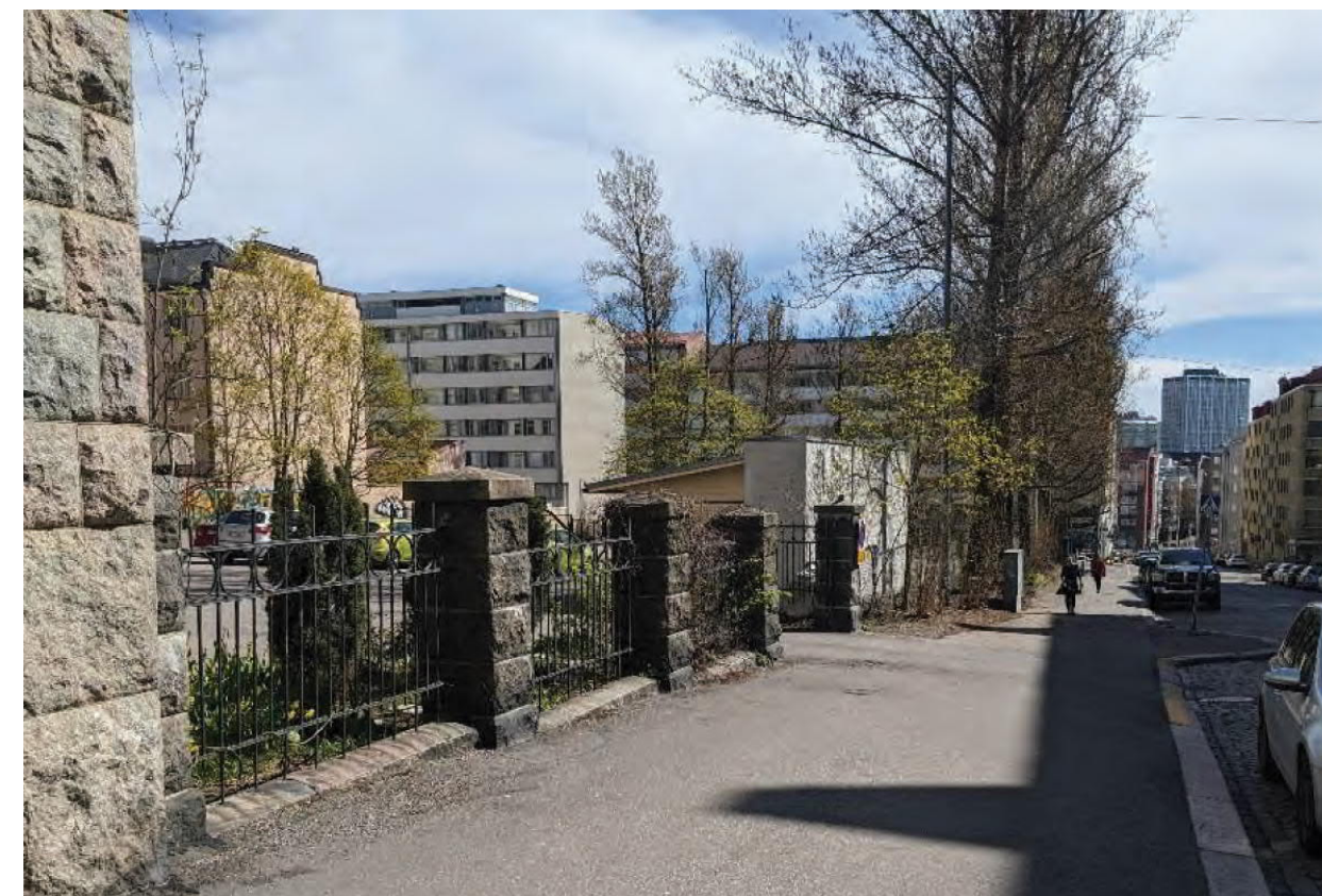
Ajoliittymä koulun pihalle Neljänneltä linjalta. Rauta-aita ja graniittipylväät ovat alkuperäisiä. Viimeistä pylvästä on siirretty ja porttia levennetty vuonna 2004 piharakennuksen toteutuksen yhteydessä. (Arkkitehtitoimisto Hormia Oy).
