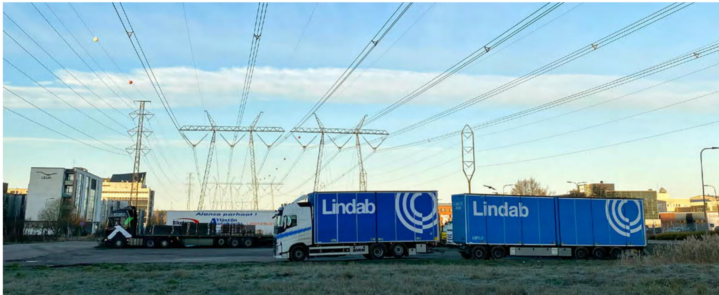
Kuva 4.21 Voimajohdot 400kV Pakkalassa. [Kuva: Tiina Hulkko].
