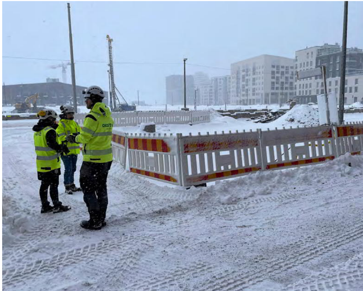
Kuva 6.28 Kalasatamasta Pasilaan -hankkeen työmaa. (Kuva: Ilari Jounila).
