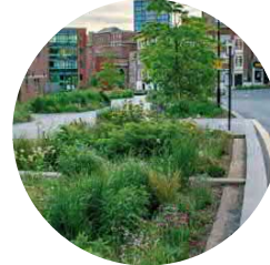
VIHERKAISTAT hulevesien viivyttykseen
