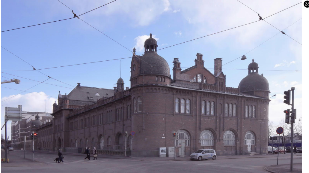
↑ Kuva luoteesta. Ravintolatilan takaovelle rakennettiin uusi lastauslaituri vuosituhatosen vaihteessa. Länsipäädyn ovet on siirretty nykyisille paikoilleen 1900-luvun alkupuoliskon aikana.
