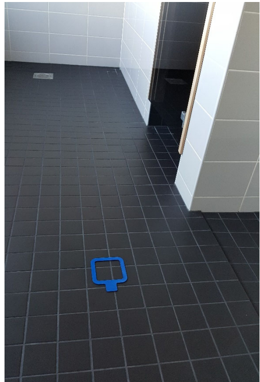
Kuva 7. Näytteenottopiste 2. Pesutila, kulkuväylä. Kuva Arja Heinonen.
