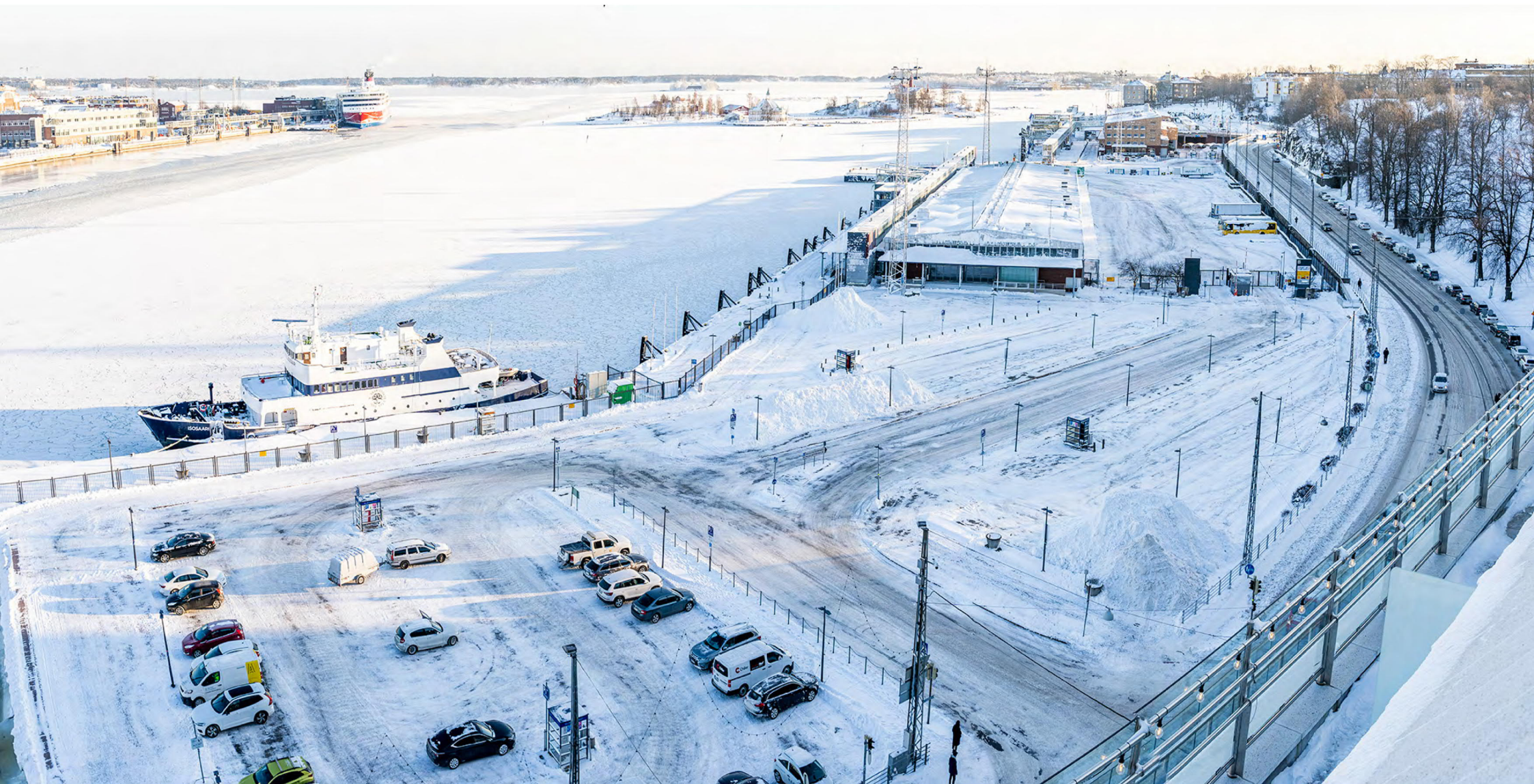
Uudisrakentamisen painopistealue kuvattuna Eteläranta 10 katoilta (Ravintola Palace) Kuva: Ilmakuvaus – Ruohonen
