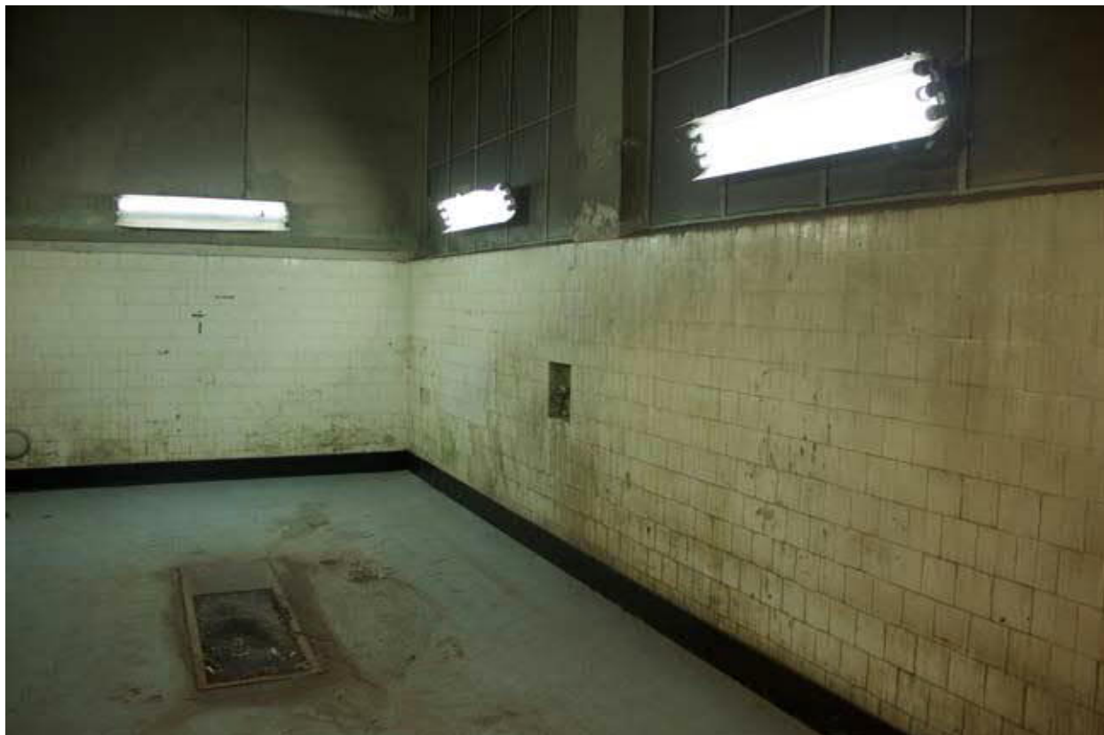
Kuvat 6.182-6.183 Näkymät autojen voitelutilaan "Smörjningsbox" 105.4
