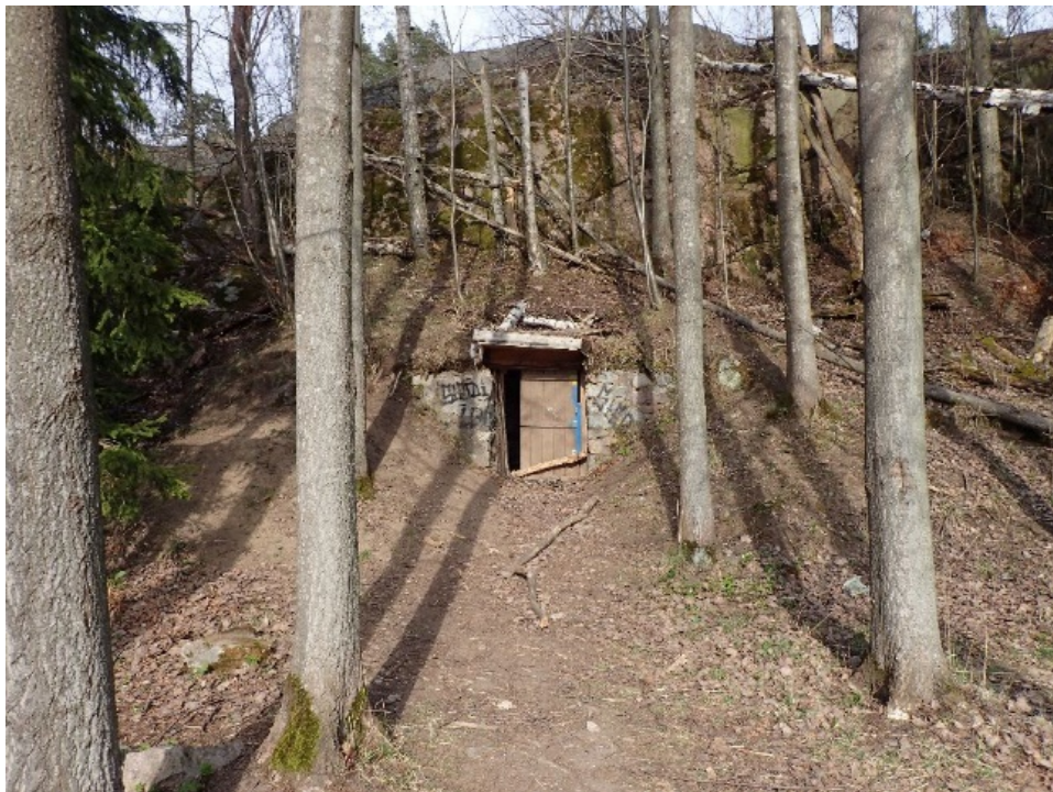
Kuva 28 Suojahuone kohteella 5 on rakennettu kallion alapuolelle pohjoisimmalla muinaisjännöksellä.
