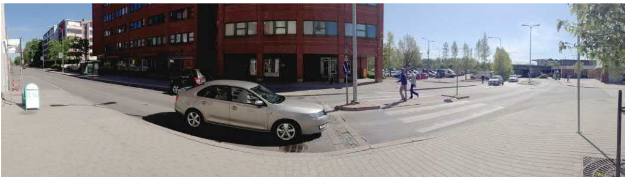
Kuva 5. Eskolantien ja Säterintien risteysalue on korotettu sen päädyissä olevilla hidastetöyryillä, jotka muodostavat tarkastelualan merkittävimmän liikennetärinän lähteen.
