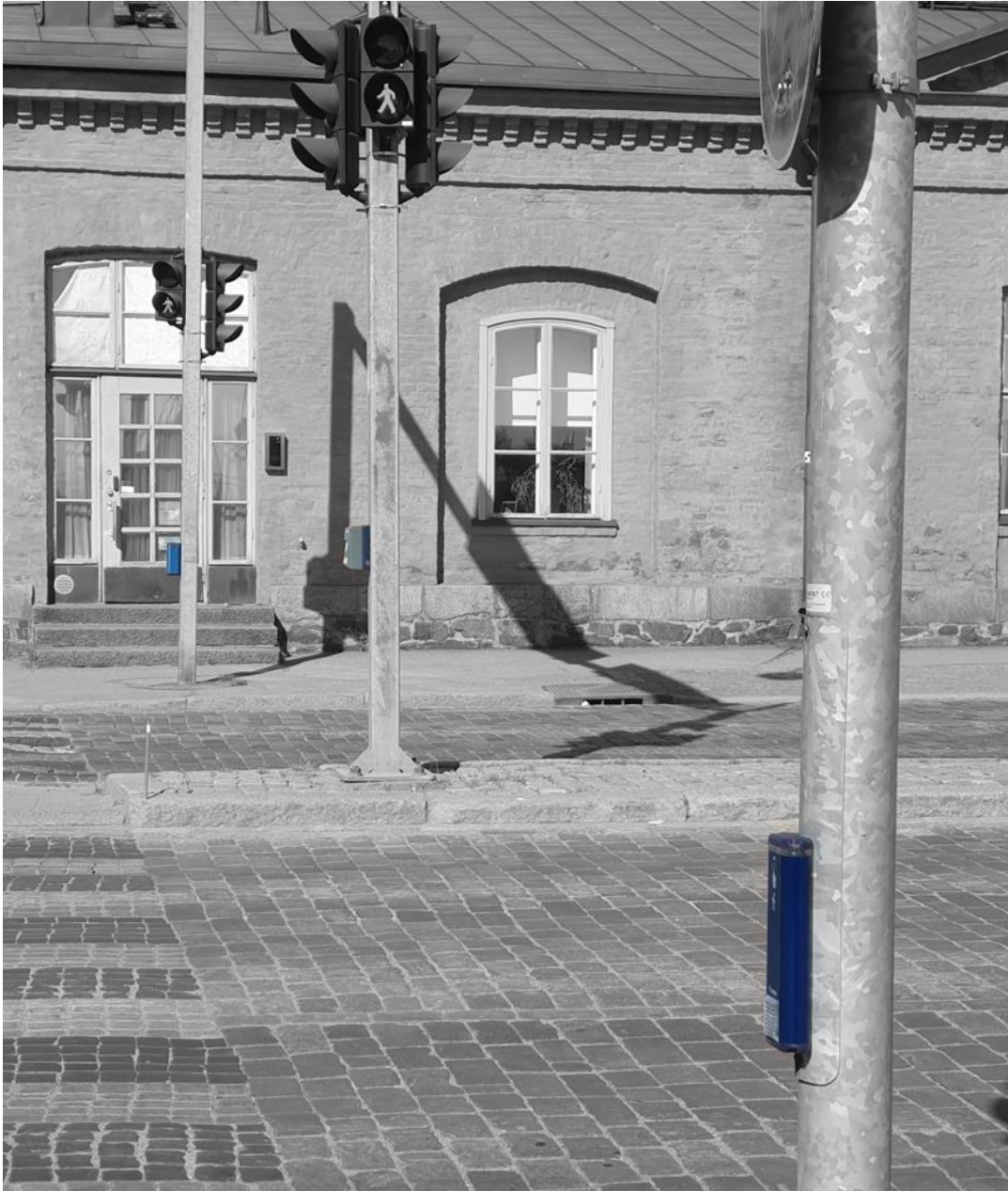
Kuva 2. Käytön kannalta huonosti sijoitetut painonapit (Nazarov, 2024)
