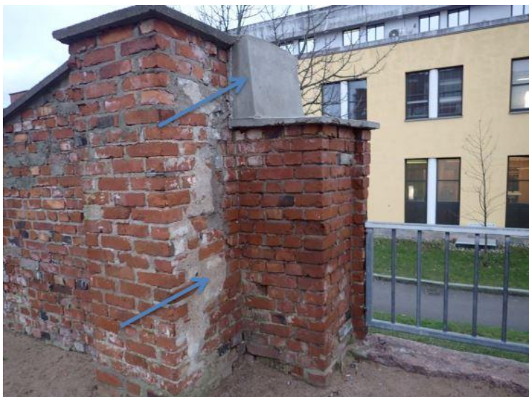
Kuva 7 N. 2 v. sitten laastilla ja betonilla paikattu tiilimuurin kohta.
