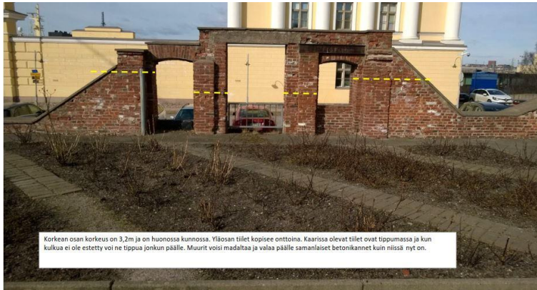
Kuva 1 Rapautunut porttiaihe poistettiin.
