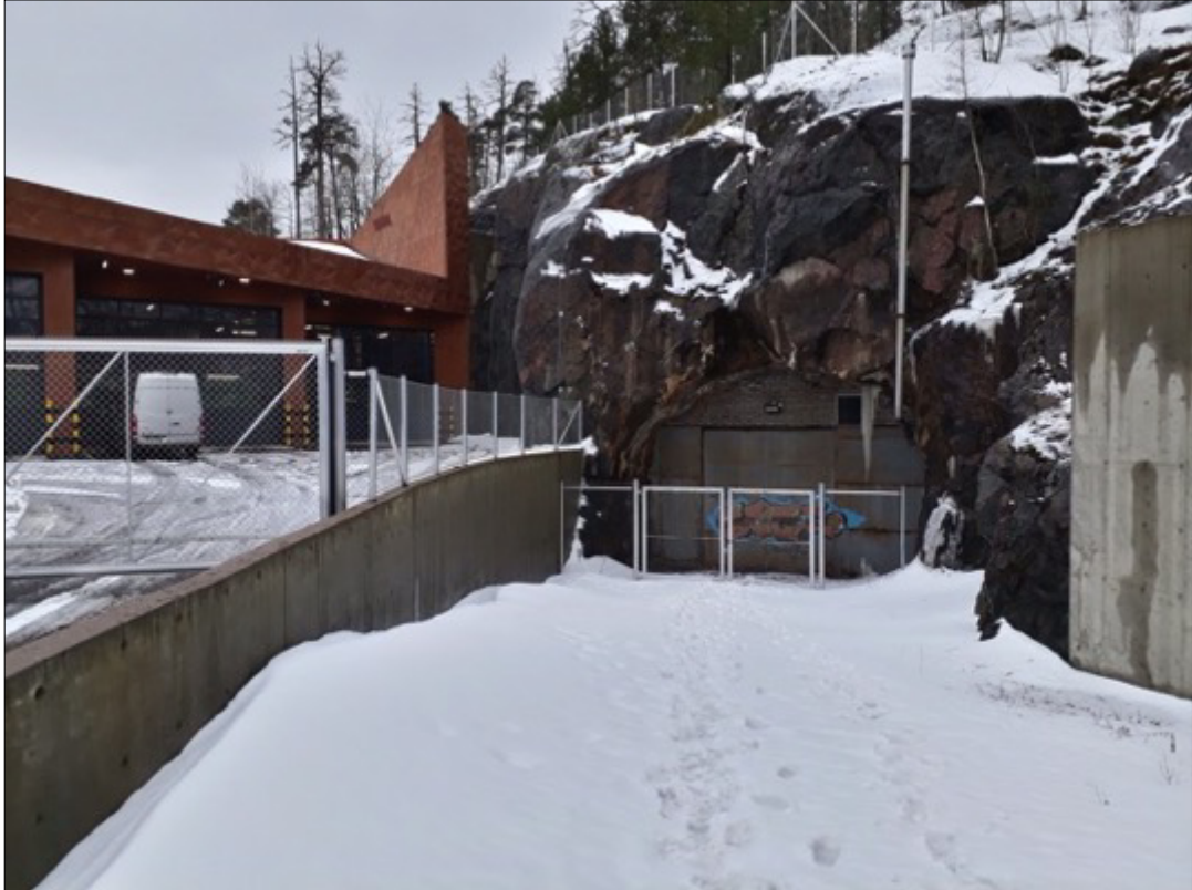
Liite 4 – Koonta-aseman viereinen pääsisäänkäynti polttoainevarastoon.
