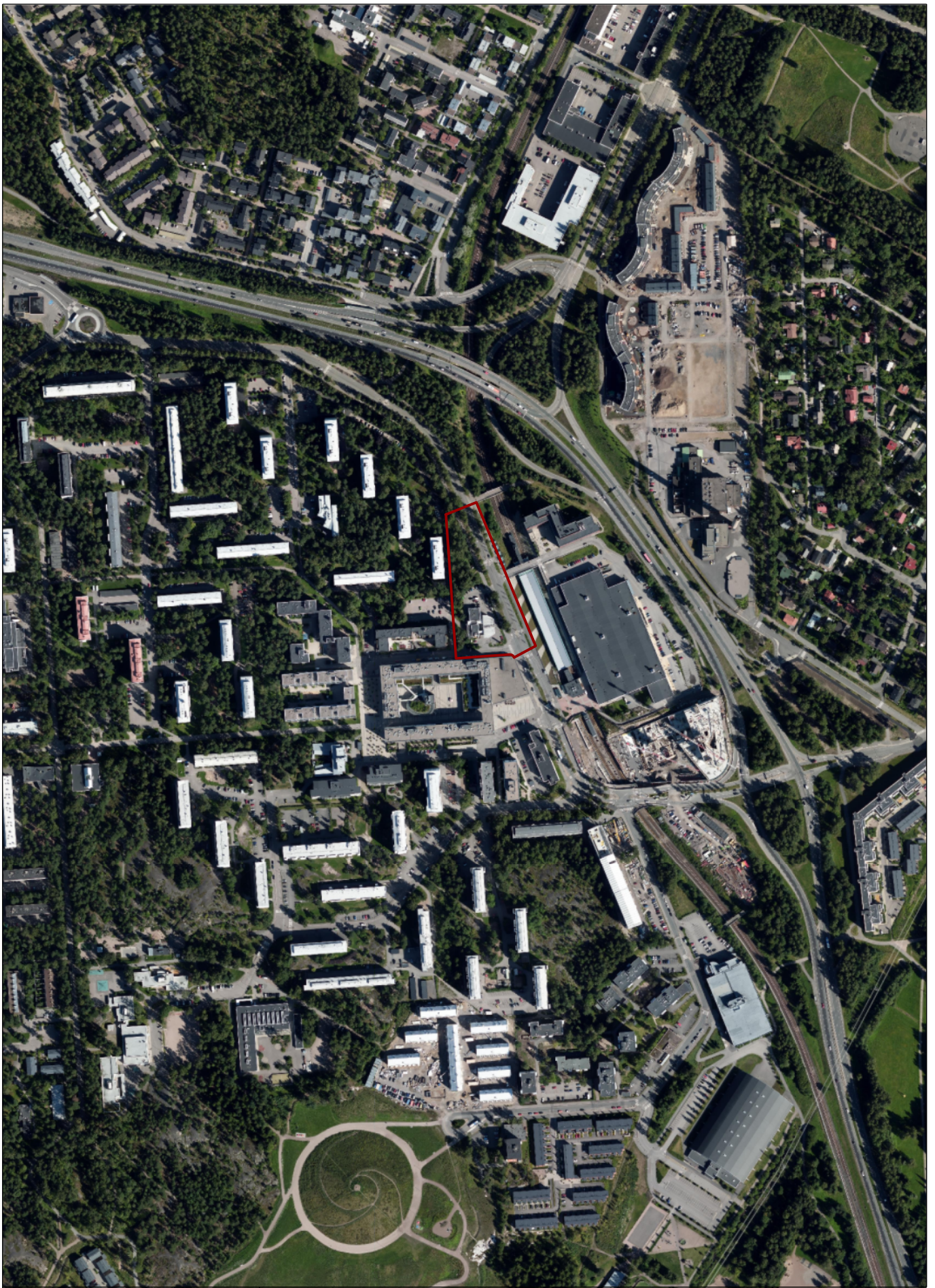
Ilmakuva Myllypuro, Kielilukio, Kiviparantie 1
